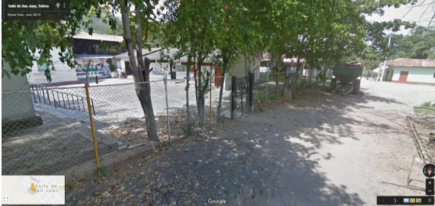
Vista Externa de la Escuela.
